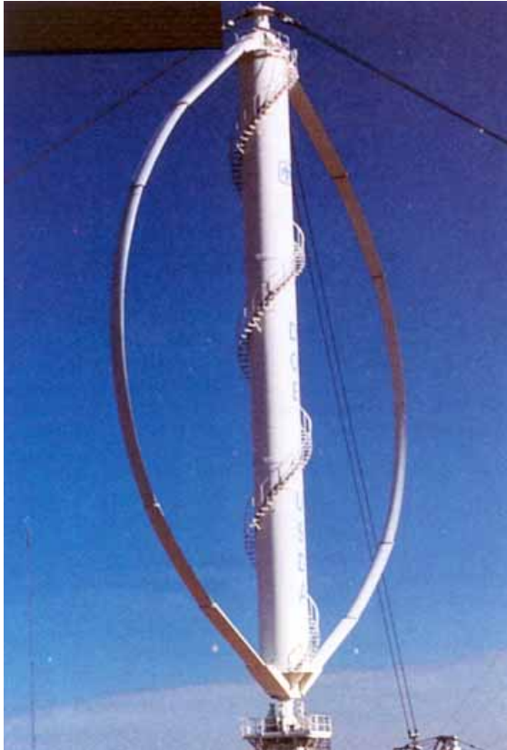
شكل W.39 عَنقَة هوائية، ذات محور رأسي، لتوليد الطاقة الكهربائية، وهي الأكبر في العالم 1993، Montgomery.
